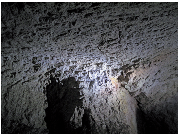
Figure A-10. S2 : Détail du plafond. Boivin©.
