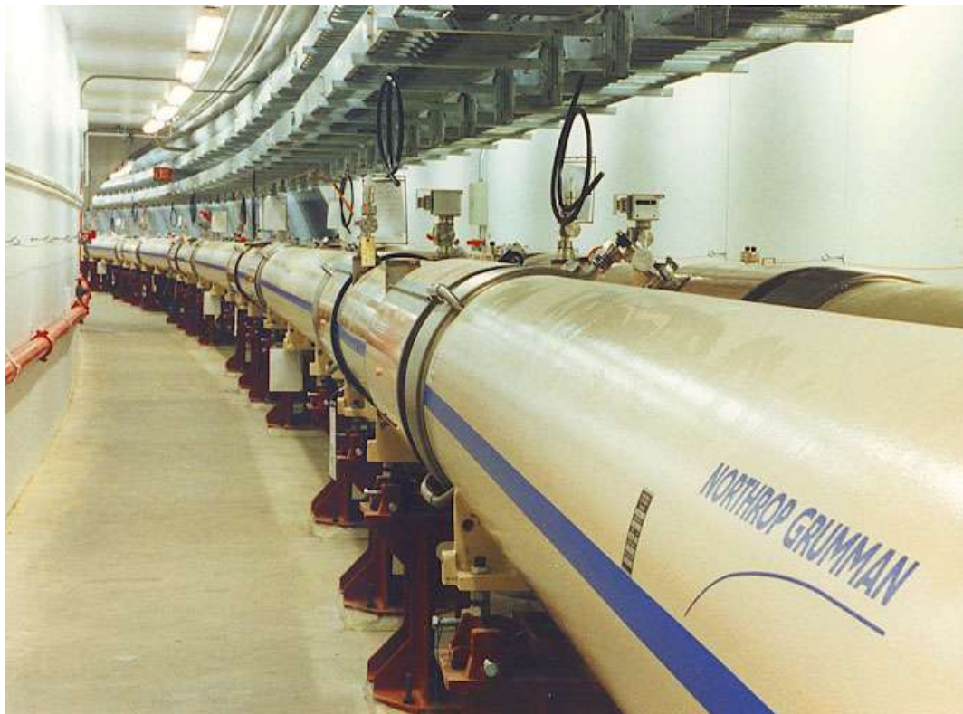
Fig.4 : le tunnel du RHIC à Brookhaven. 5
