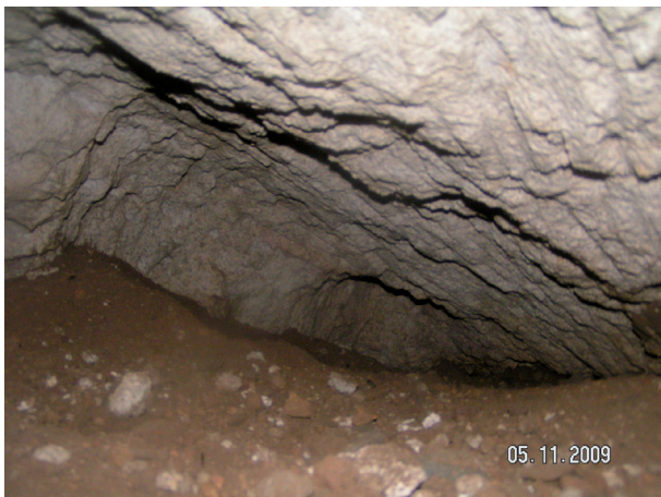
Figure A-8. S2 : Remplissage incomplet de la cavité. Miallier©.
