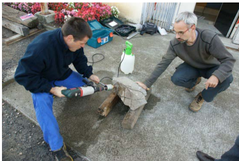
Fragment d'architrave : carottage en cours (MC dépôt Mermoz)
