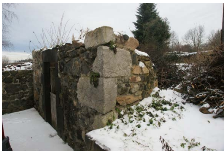
Figure 6. Blocs d'angle en trachyte dans un vieux bâtiment à La Font de l'Arbre
